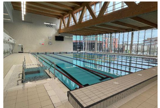
Die Stadt Exeter realisierte das erste Passivhaus-Hallenbad in Großbritannien. © Exeter City Council
