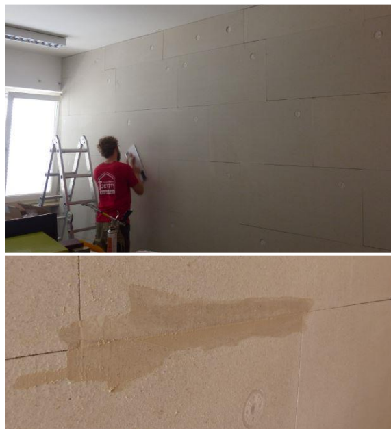
Innendämmung mit EPS-Verbundplatten in Eigenarbeit: Das Passivhaus Institut zeigt beim Passivhaus-Abend am 25. Januar, worauf es dabei ankommt. © Passivhaus Institut
