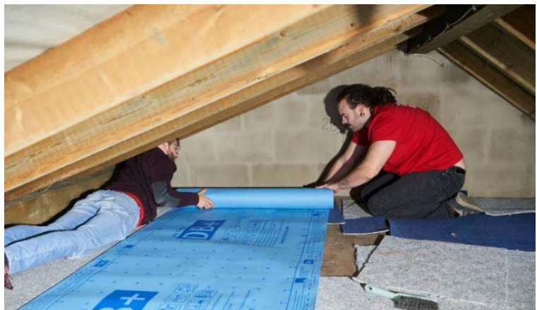
Thema des Passivhaus-Abends im Dezember: Energiesparmaßnahmen selbst umsetzen. Diesmal geht es um die Innendämmung sowie die Dämmung von Kellerdecke und oberster Geschossdecke (Bild). © Passivhaus Institut
