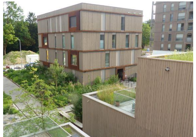
Das Passivhaus-Quartier mit 36 Wohneinheiten besteht aus acht Gebäuden und beinhaltet Nebenanlagen wie eine Gemeinschaftsküche. © PHI
