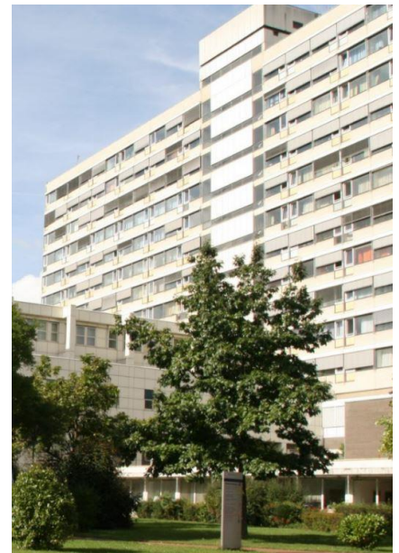
Das Bestandsgebäude des Klinikums aus den 1960er Jahren. © Klinikum Frankfurt Höchst
