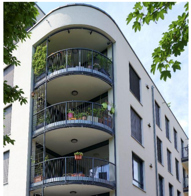
Mehrfamilienhaus im Passivhaus-Standard: Eine Exkursion zur Wuppertaler Malerstraße ist eingeplant. © EnergieAgenturNRW, F. Wiedemeier
