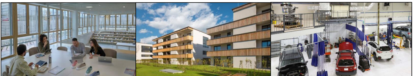
3 x Passivhaus-Standard: Neues Firmengebäude des spanischen Schuhherstellers Victoria (l.). Energieeffizienz ist Grundlage für bezahlbares Wohnen und sozialen Wohnungsbau wie hier in Kufstein von der österreichischen Wohnbaugesellschaft Neue Heimat Tirol (m.). Im kanadischen Alberta gab es zum 50. Firmenjubiläum einen energieeffizienten Neubau des Autohauses samt Werkstatt (r.). © Victoria (l.), NHT (m.), G. Scott (r.)
