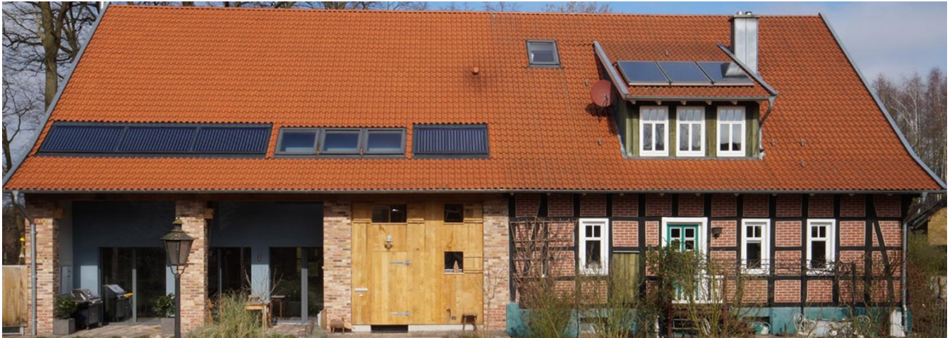
Neu in alt: Im nordrhein-westfälischen Steinhagen integrierte die Baufamilie ihr Passivhaus (links) in eine über 100 Jahre alte Remise. Auch das ZDF fand das Projekt beeindruckend und strahlte dazu gerade einen TV-Beitrag im Morgenmagazin aus. Link zur Mediathek , Bericht ab Minute 25.20. ©Thomas Spooen
