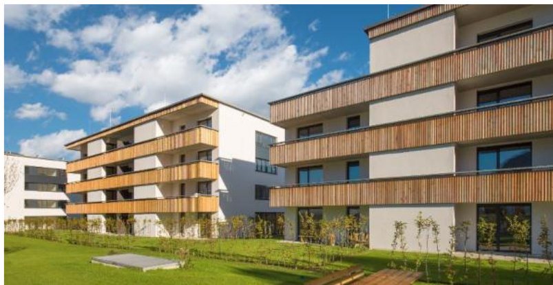
Energieeffizient und kostengünstig: Sozialer Wohnungsbau der Baugesellschaft Neue Heimat Tirol in Kufstein. © NHT
