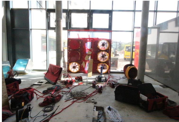
Der Drucktest im Passivhaus-Krankenhaus in Frankfurt-Höchst. Im Vorfeld des Tests musste auch sicher gestellt werden, dass die über 1000 Fenster in den rund 2000 Räumen geschlossen sind. © Passivhaus Institut
